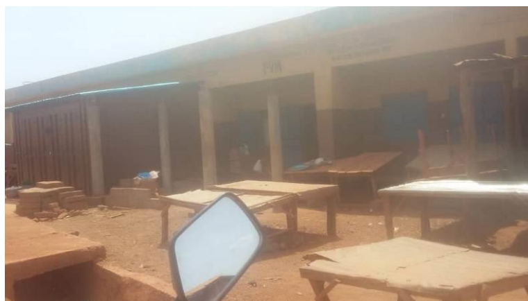
Photo 11 : Blocs de boutique dans le marché de Founougo
