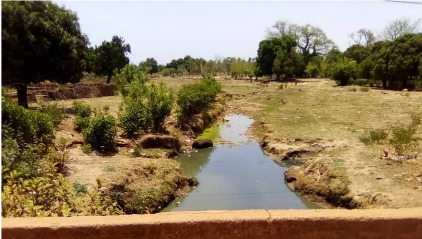
Photo 13 : Retenue d'eau de Toura Prise de vue : Cabinet PIC, mai 2019
